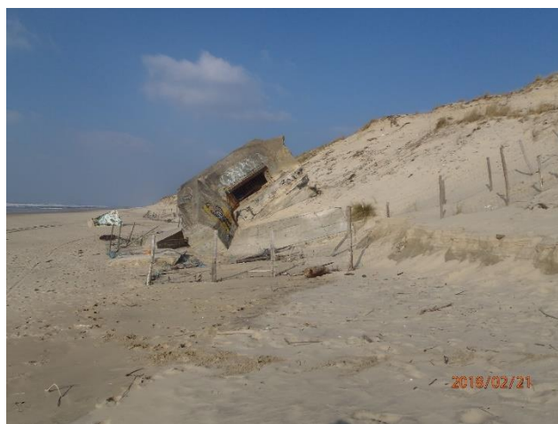
Illustration 1 : blockhaus au nord de Lacanau, la clôture du haut de plage était presque ensevelie en début d'hiver et jusqu'à fin décembre. Crédit photo : ONF
