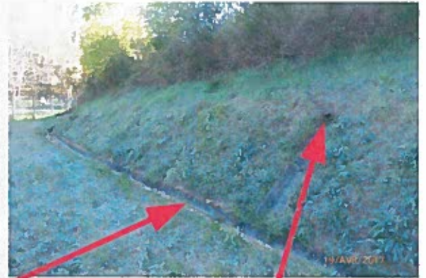
Sortie d'un drain en pied de la digue
