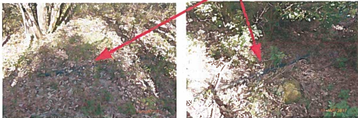
Canalisation envoyant les eaux vers la station de traitement de Bellezane
