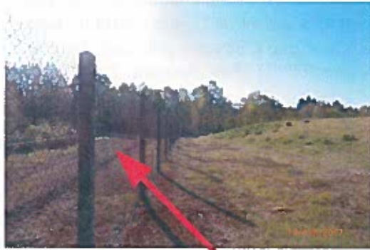
Clôture de 2 mètres ceinturant le stockage de résidus de traitement
